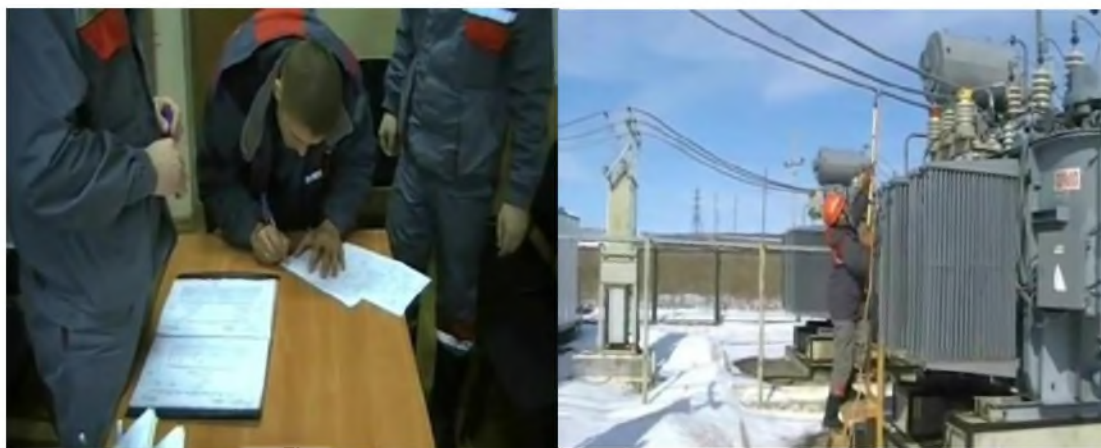
Рис. 2. Скриншоты кадров из учебного фильма «Текущий ремонт силового трансформатора 35кВ»
