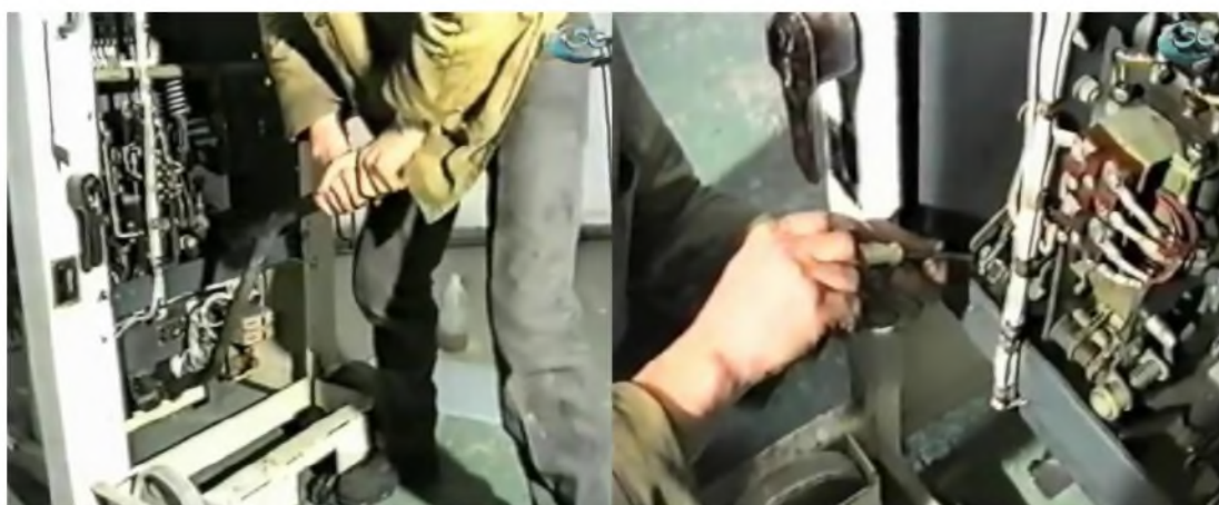
Рис. 3. Скриншоты кадров из учебного фильма «Ремонт, наладка и испытание выключателя серии ВМПЭ 10»
